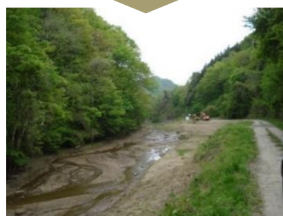
整備された砂防堰堤上流部
