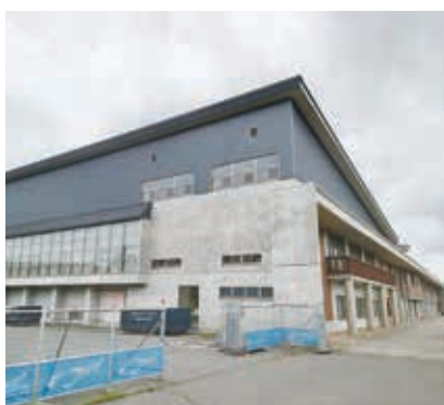
改修中の北部小学校
