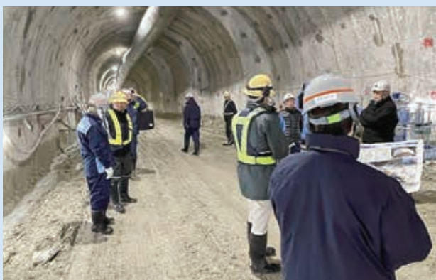
トンネル工事の現地視察の様子
