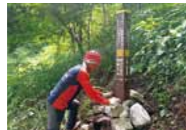
登山道の案内標柱を設置
