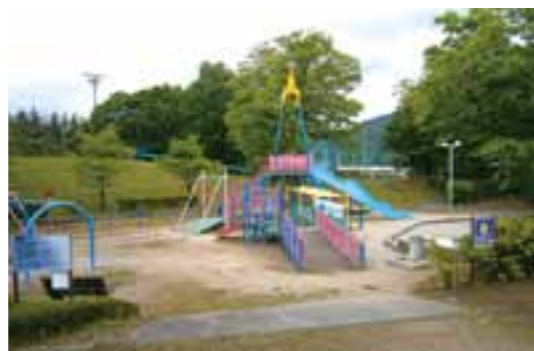
子どもたちの安全のための修繕工事
