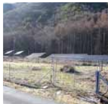
事業者が倒産した太陽光発電施設
