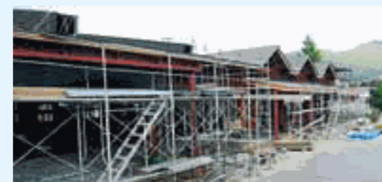
建設中のこまくさ幼稚園
