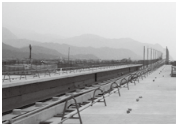
建設が進む新幹線（糸魚川地区）
