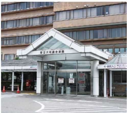
PCR検査センターが設置された大町病院
