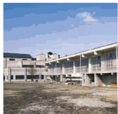
現在稼働中の浄水センター。当初予定していた事業は終了しているはずだが…
