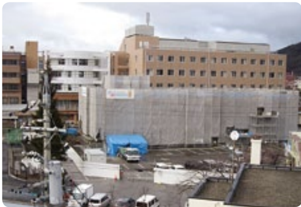
災害拠点施設を建設中の大町病院
