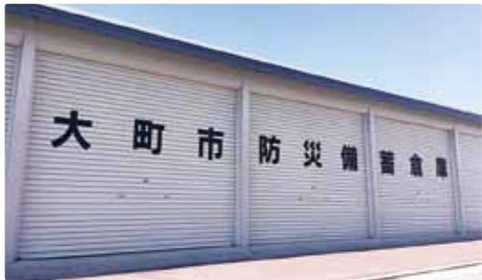
地理的に孤立が予想される地域への 防災備蓄倉庫の整備及び備蓄品の拡充を急ぐべき！ 市庁舎前に設置されている防災倉庫
