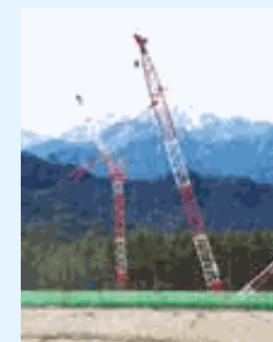
建設工事が進む「サントリー天然水北アルプス信濃の森工場」
