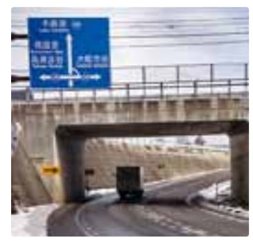
地域に優しいオリンピック道路と槍ヶ岳線交差の掘削道路
