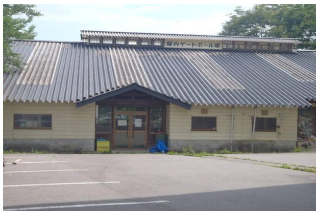
屋内ゲートボール場（コート1面） （附帯施設）
