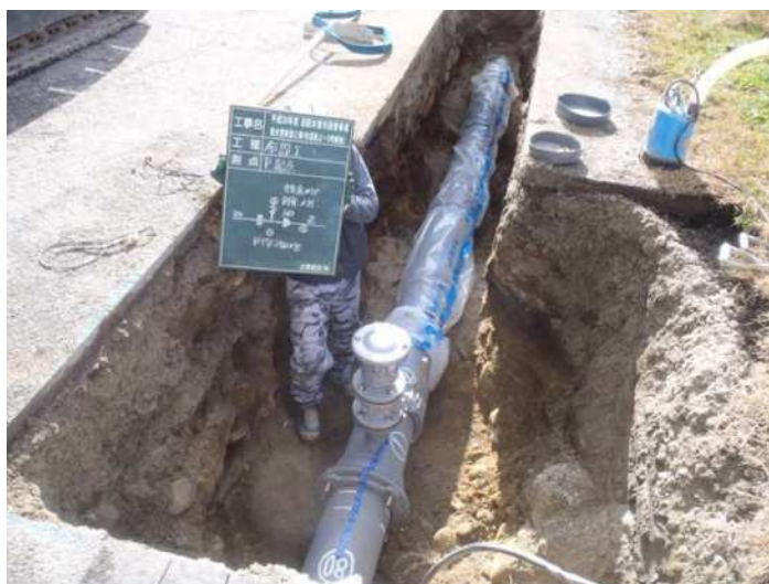
耐震管（ダクタイル鋳鉄管 DCIP-GX 形）
