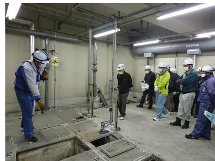
前処理室（地下）
