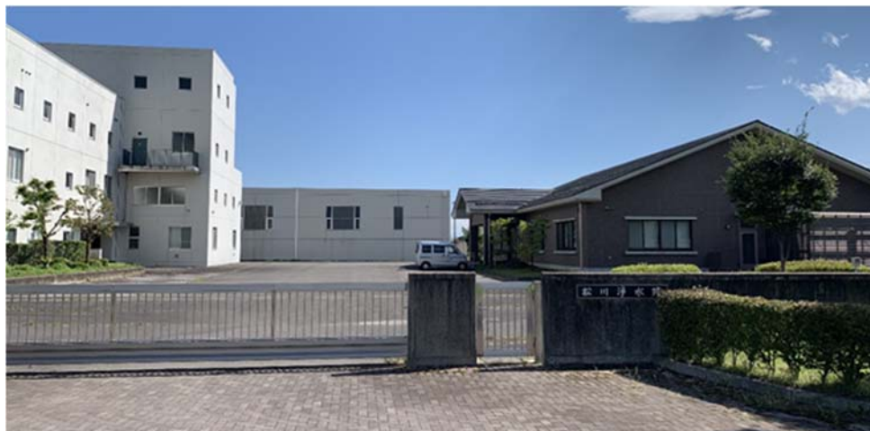
(特定環境保全公共下水道 松川浄水苑)
