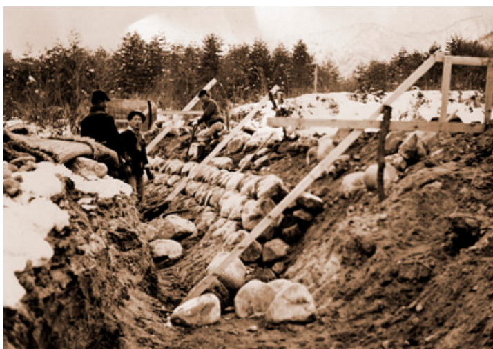
矢沢水源の護岸石積工事
