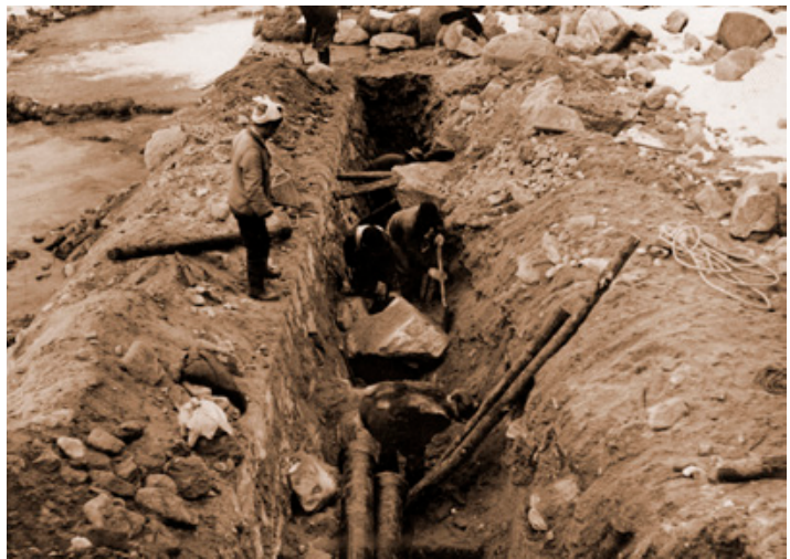
送水管の鹿島川横断工事
