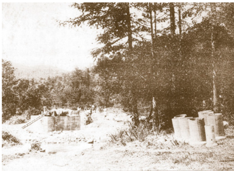
居谷里水源の工事
