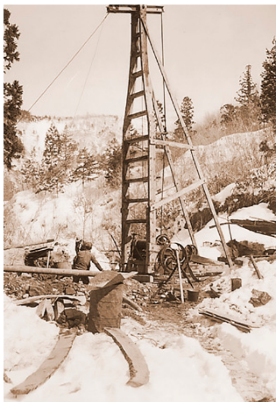
宮本水道の水源工事
