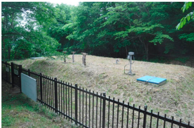
学校上第2配水池
