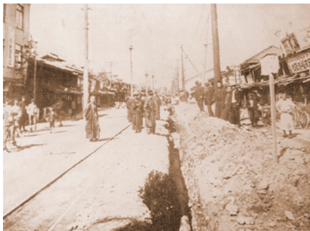
大町下仲町通の鑄鉄管埋設工事の状況
