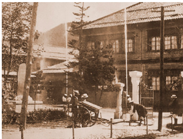
大町小学校前での消火栓放水訓練
