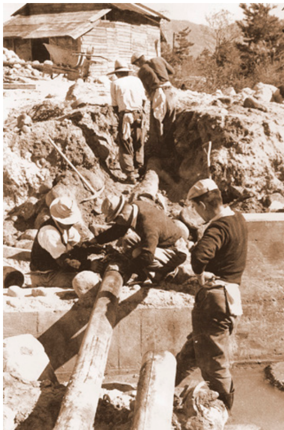
常盤水道の送水管和田川横断工事
