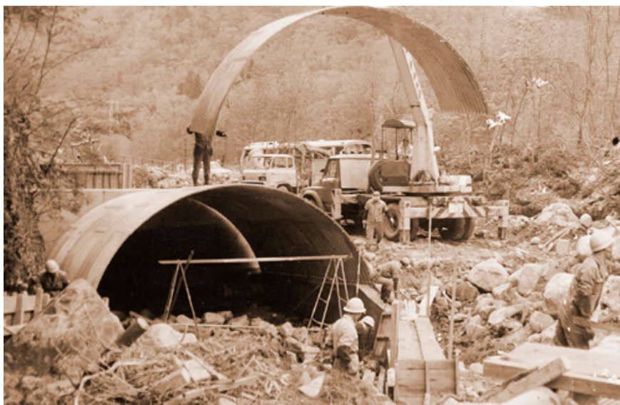
上白沢水源のコルゲートパイプ設置の状況
