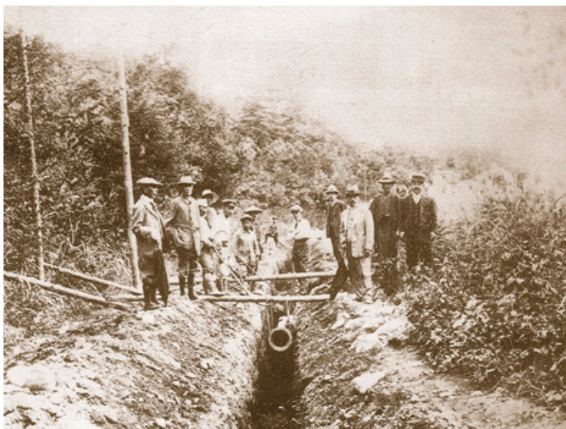
水源地和配水池間の鑄鉄管理設工事
