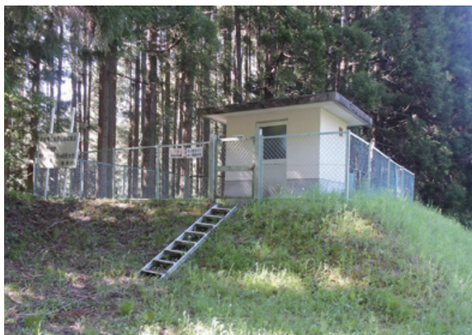
中の崎配水池
