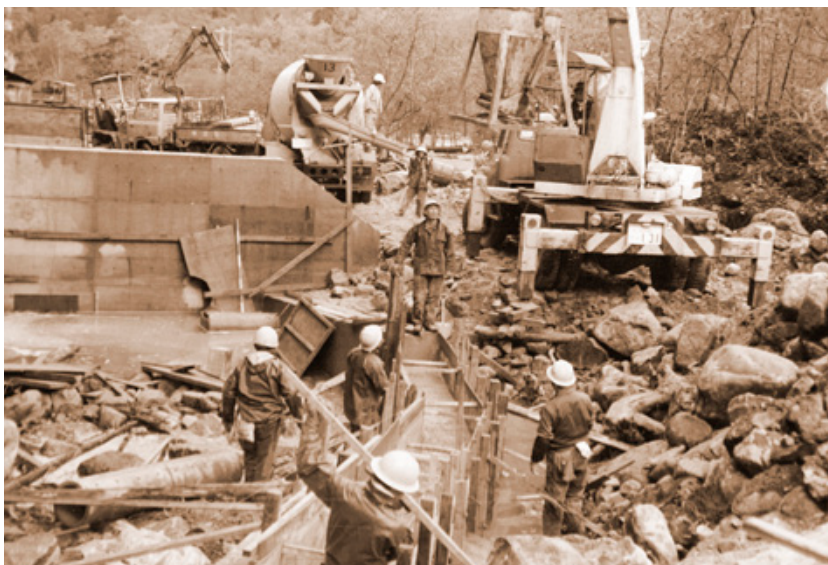
上白沢水源工事の状況
