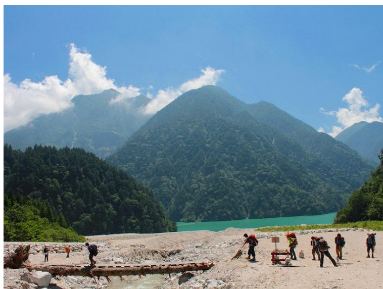
図3.6 濁り沢丸太橋
