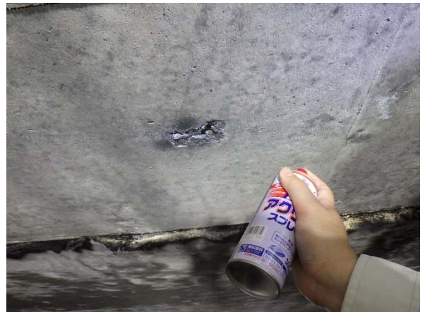
応急処置(防錆処置)状況
