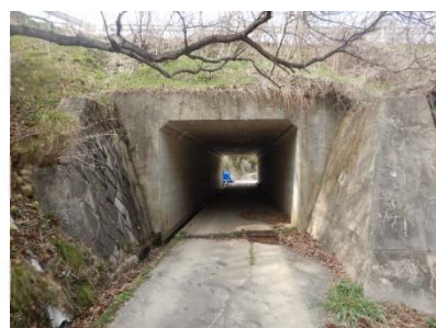
瀬口トンネル
