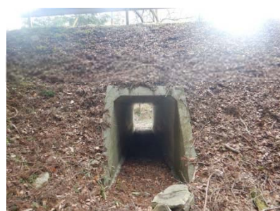
小松尾トンネル
