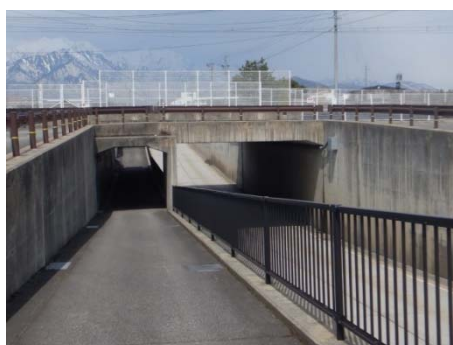
小松原跨道橋
