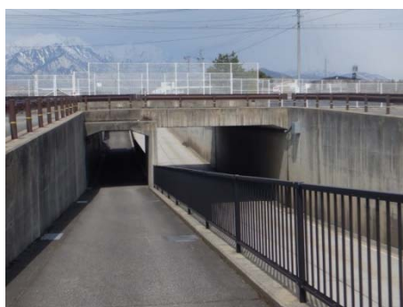
小松原跨道橋
