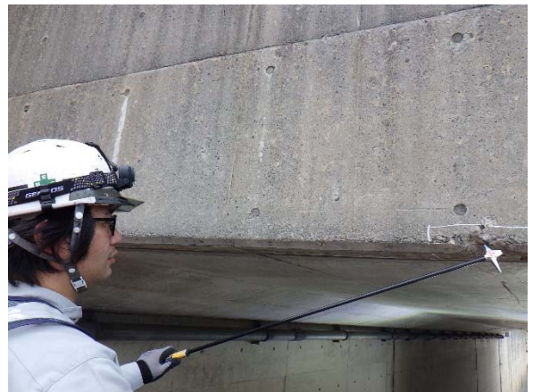
応急処置(たたき落とし)状況
