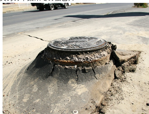
マンホールの浮上
