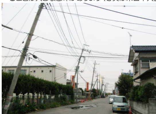
液状化による電柱の倒壊
