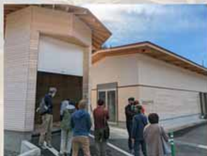
役場の冷暖房をすする木質バイオマスボイラー（冷暖房）は町内で作られる木質チップを燃料として運転される。
