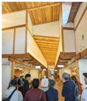
地域材を豊富に使用して新築された木曾町役場新庁舎
