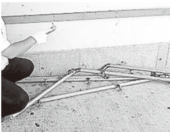
壊されたトイレの手すりを撤去
