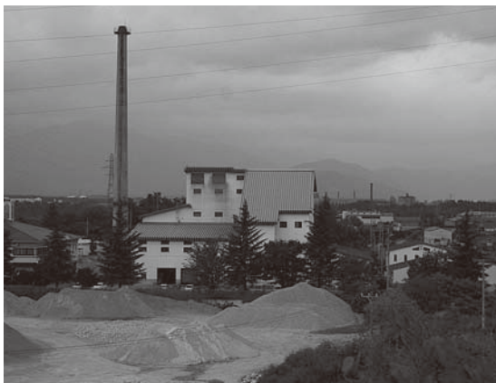
老朽化激しい現ごみ焼却場
