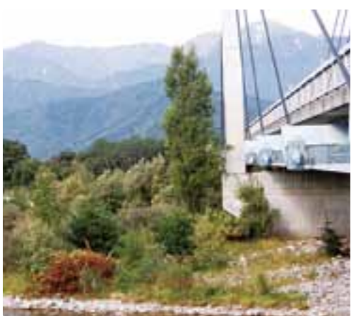
河川内に繁茂している樹木(宮本橋付近)
