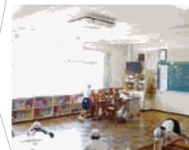
エアコンが設置され快適な教室
