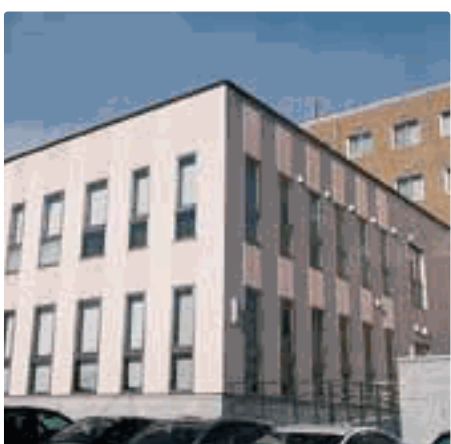
損益悪化要因の一つとなっている南棟「さくら」
