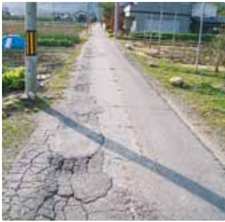
市道のひび割れスマホでも送れるように
