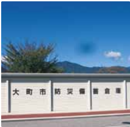
市役所に整備されている防災倉庫。災害時の必要物資はここから運ばれる
