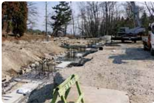
基礎工事中新設水工場
