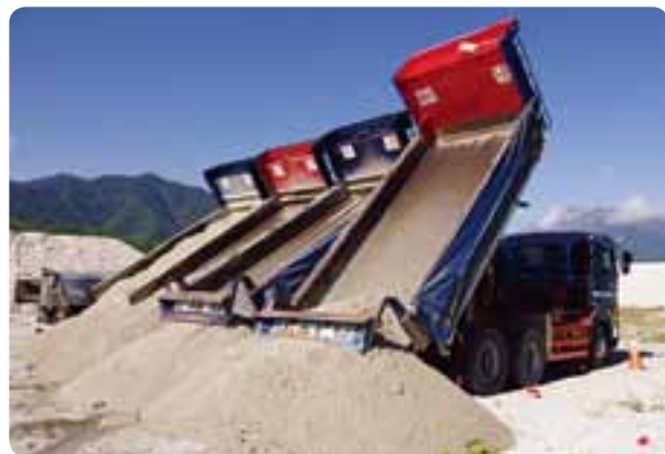
高瀬ダムの堆砂を運ぶダンパカー
