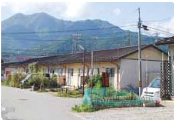
建て替え予定の上一団地
