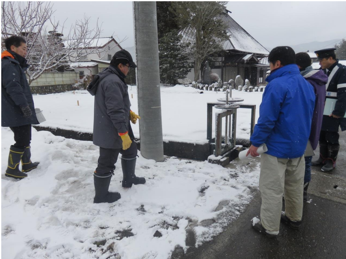
【合同点検（平成30年2月）・大町北小学校区内】
