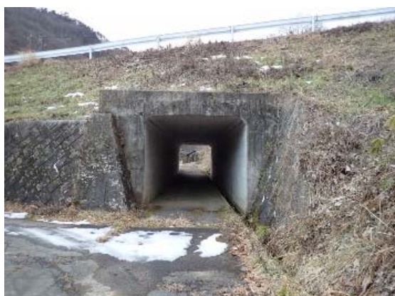
瀬口トンネル
