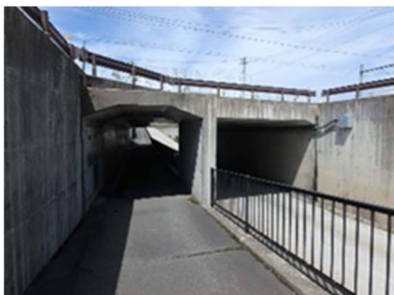
小松原跨道橋
