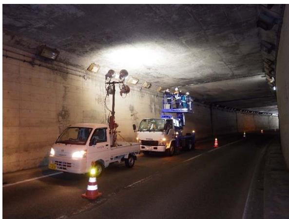
アーチ部点検状況
