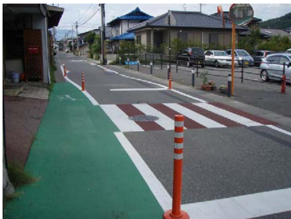
グリーンベルトの設置
