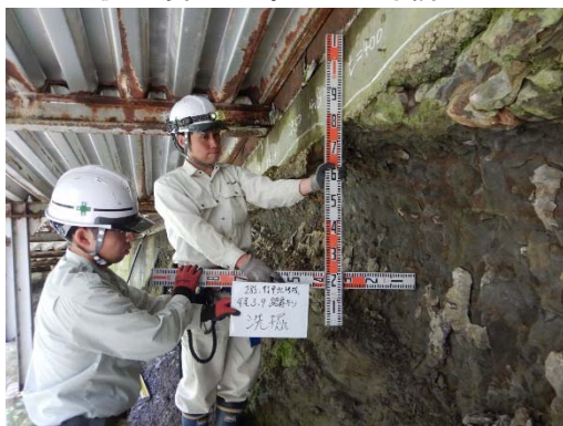
健全度Ⅲ：野平北1号橋
