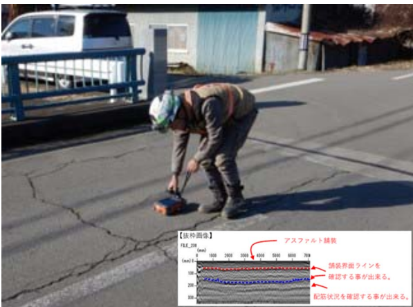
電磁波レーダ法による床版調査
