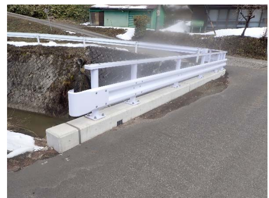
写真 6. 高欄補修 万中 2 号橋 (高欄更新)
