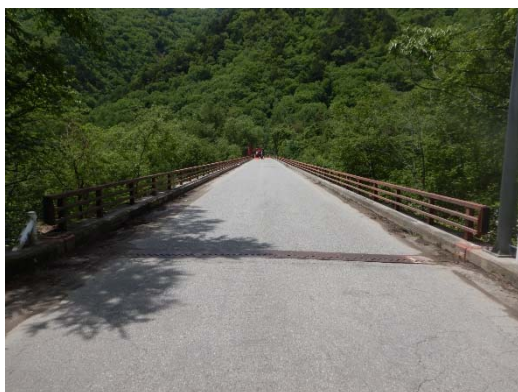
健全度Ⅰ：籠川大橋
