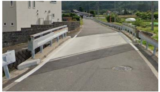
写真 2. 伸縮装置補修 K-29-2 (橋面・伸縮装置補修)
