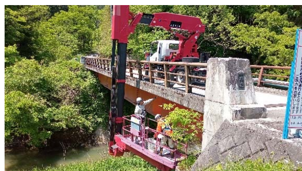
橋梁点検車による点検
