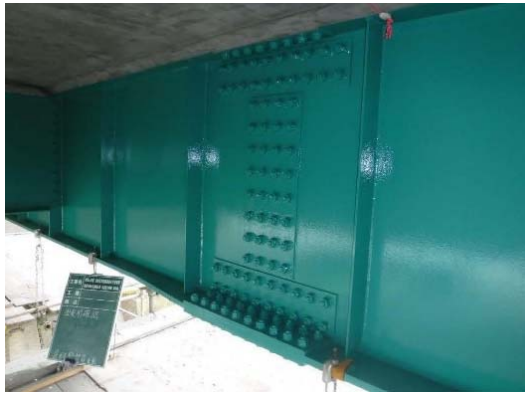
写真 3. 主桁補修 満仲橋 (主桁・塗装塗替工)
