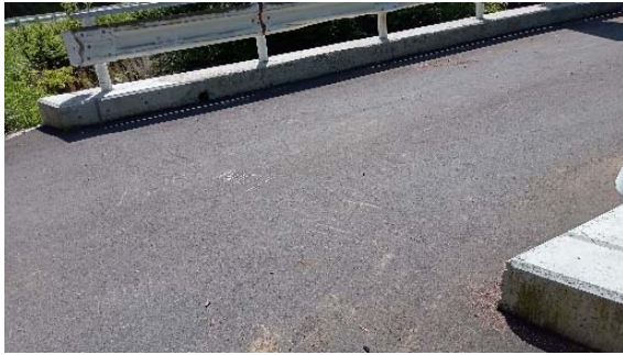
写真 1. 舗装補修 日影 1 号橋 (橋面・舗装更新)
