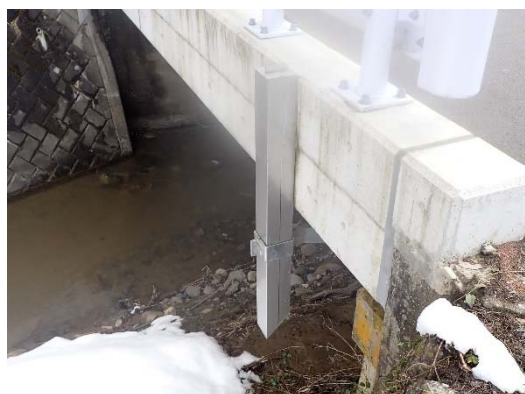
写真 5. 排水装置補修 万中 2 号橋 (排水管更新)
